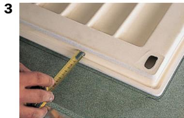
**1. Poser l'évier à l'envers sur le plateau dans lequel il doit s'encaster. Déterminer son emplacement en largeur et en longueur.**
