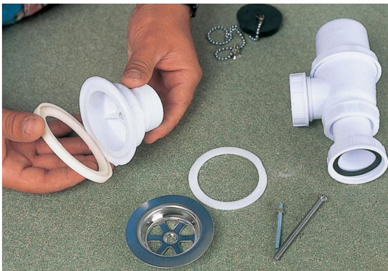
**1. Démontez la bonde en dévissant la grille, sans oublier de repérer la disposition des joints d'étanchéité. Poser le joint en caoutchouc sur la bonde.**
