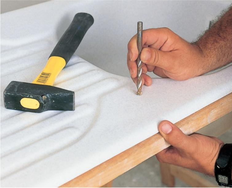
1. Poser l'évier à l'endroit sur des tréteaux. Repérer avec le doigt l'emplacement du prétrou.
