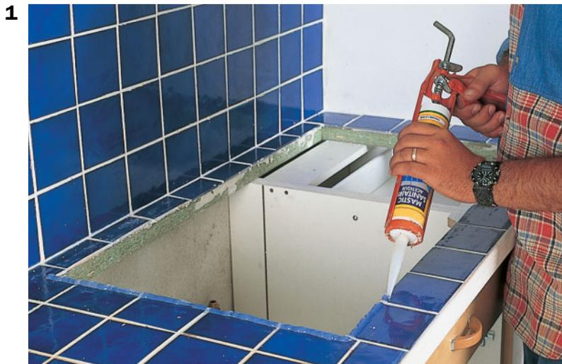
**1. Déposer un cordon assez épais de mastic silicone sur le pourtour du trou d'encastrement.**
