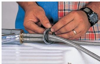
6. Enfiler le joint et, éventuellement, la bague de rotation du bec, puis le robinet dans le trou préparé.
